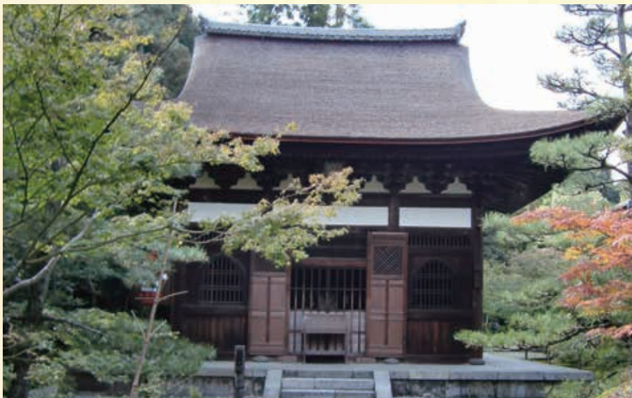
重要文化財・酬恩庵本堂
