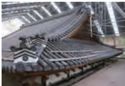
屋根瓦を葺くに当たっては、当初より残る瓦を東面の蓮池からよく見える妻面に配置し、新しい補足瓦はその他の面に葺き上げました。
