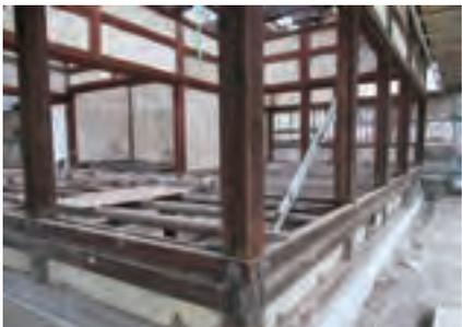
この建物は天井上の桁、梁の組手が当初から水平面の剛性に弱点が見られ、主要構造部の傾斜の原因と考えられました。
