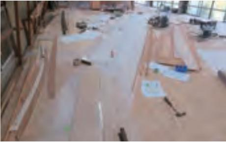
軒回りの修理は、解体の際に実測したデータと部材に残された痕跡を頼りに、弊社工場にて実物大の図面（原寸図）を描きました。
