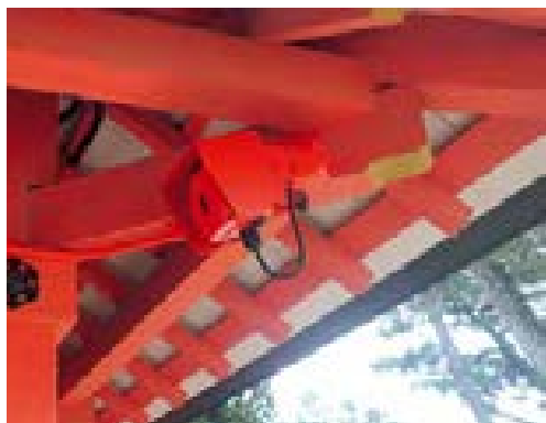
指定色を施し意匠に配慮した、三波長検知の炎感知器
